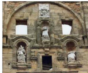
Convento de los Trinitarios
